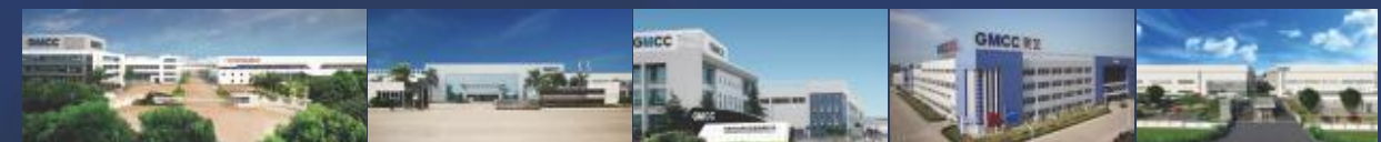
广东顺德（大良） Shunde, Guangdong
